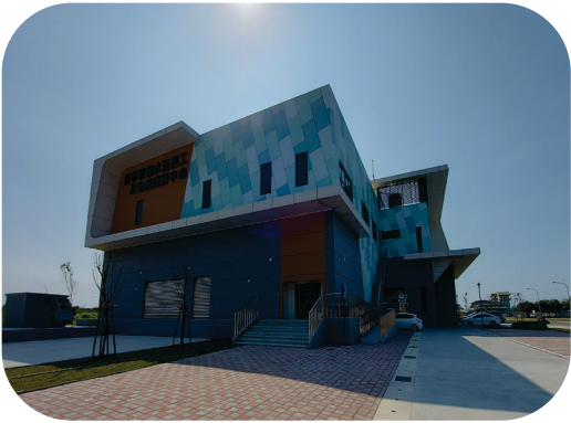
將軍智慧水產加工及物流運籌中心 智慧水產示範基地興建工程 (圖片來源：本處於114年3月21日拍攝)
